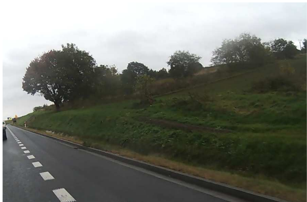
DK4 Grunty rolne oraz zadrzewienia wzdłuż odcinka drogi krajowej (powiat bocheński)
