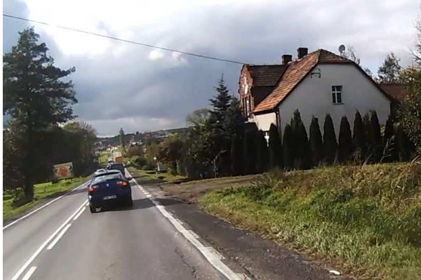
DK52 Zabudowa jednorodzinna w miejscowości Inwałd
